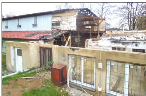
Demolice požárem zničené sokolovny
