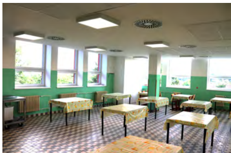
Snížení stropu školní jídelny a instalace akustických panelů
