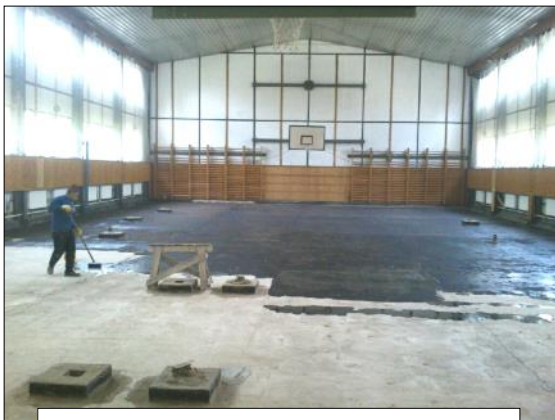
Práce na nové podlaze tělocvičny
